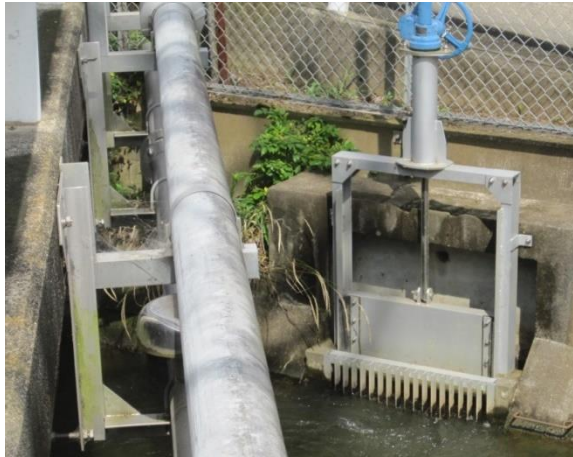
写真4. 橋のすぐ脇にある分水工
