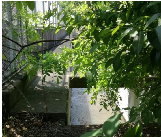
写真5. 常磐道を越える橋に平行する樋
