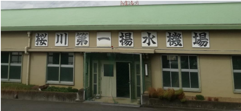
写真1. 桜川第一揚水機場
