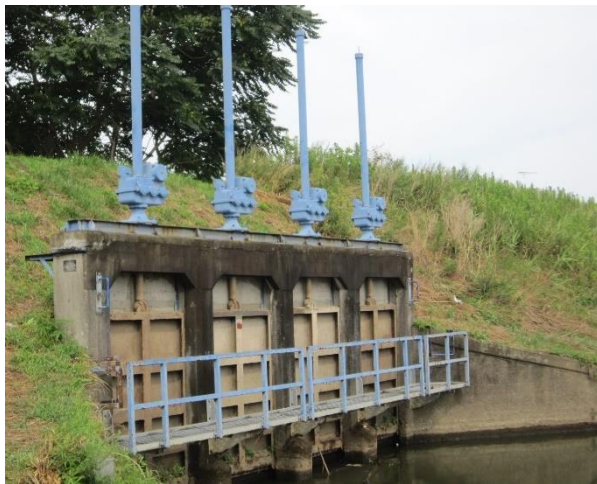
写真2. 桜川からの取水口
