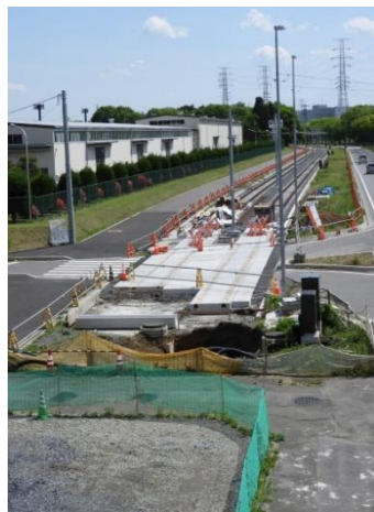
工事風景（別日撮影）
