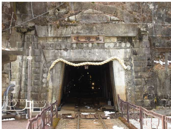
図5 通洞坑の入口
