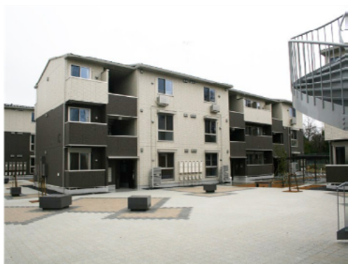
写真 1：グローバルビレッジの外観
