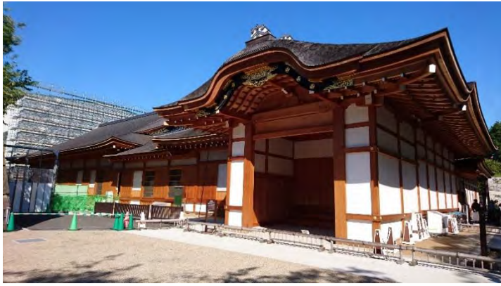
↑本丸御殿（画像左奥で、まだ工事が続けられていた）
